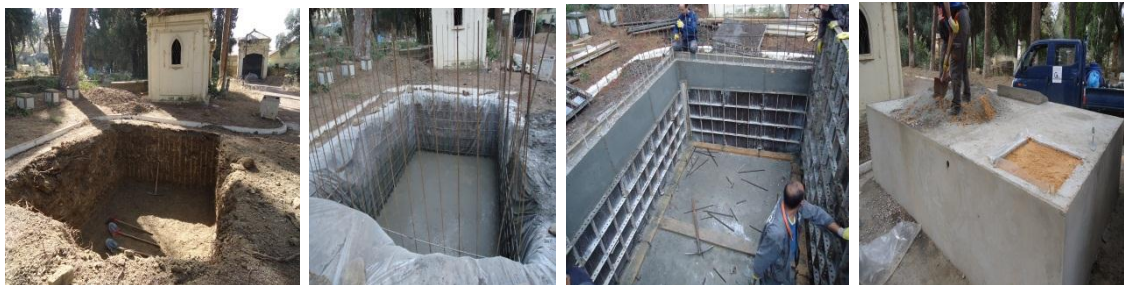
Construction d'un ossuaire
