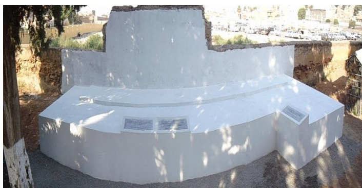
Construction des 3 ossuaires
